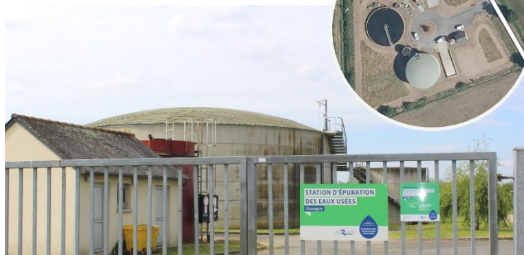
La station d'épuration située à la Robinais
